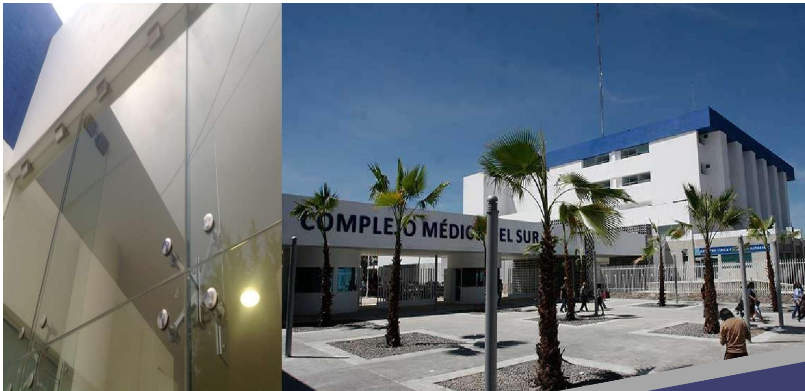
Hospital General del Sur, Puebla, Pue.
